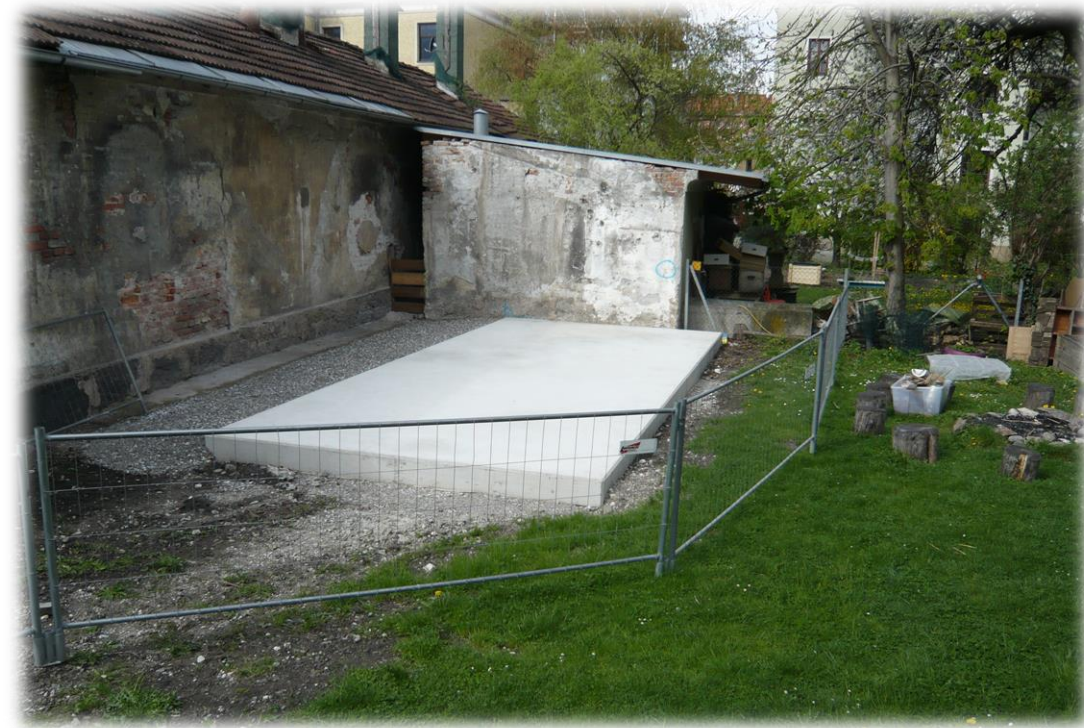
Die frisch betonierte Bodenplatte
