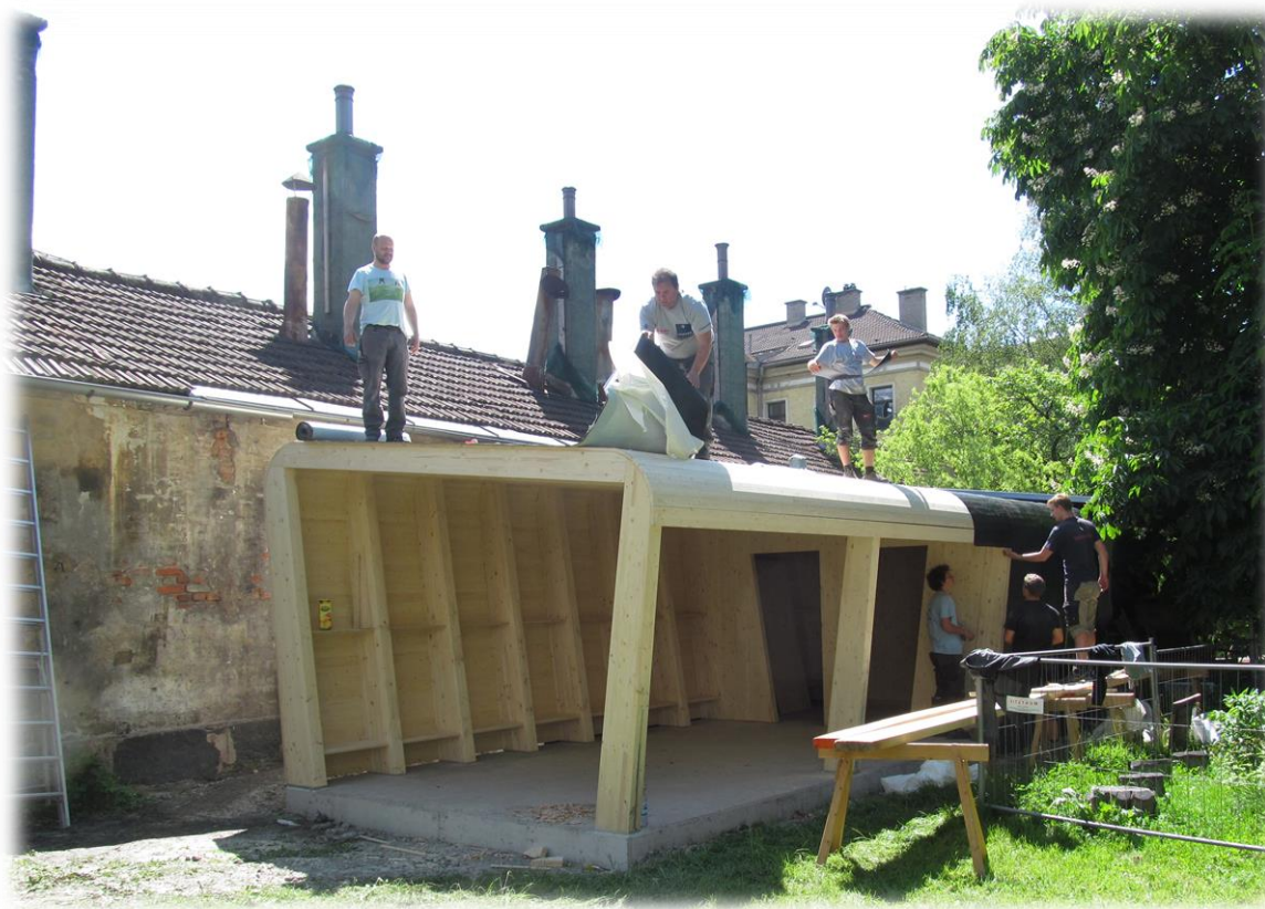
Die Montage der Holzkonstruktion
