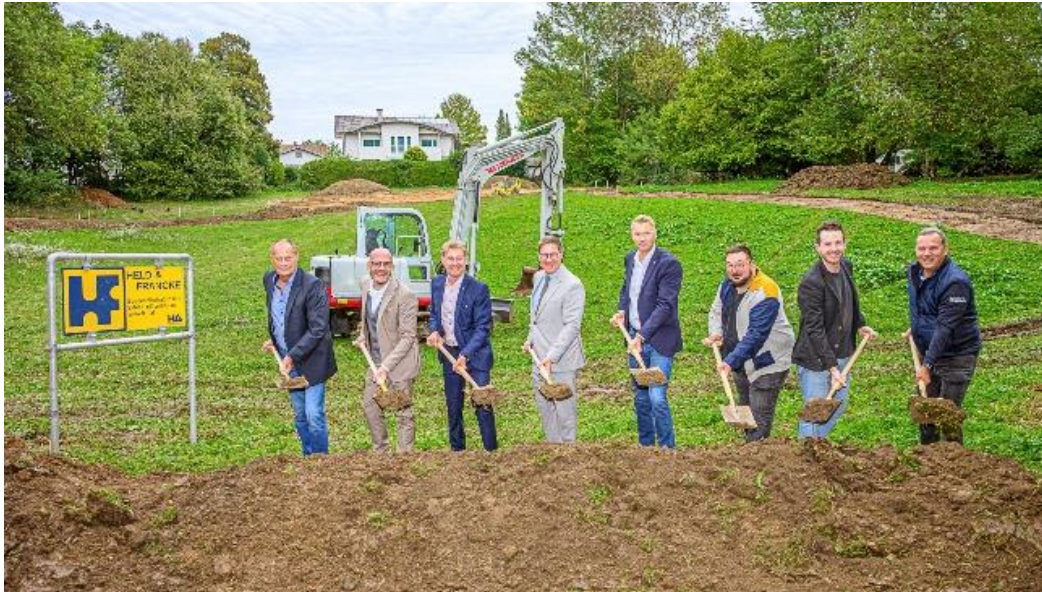
Spatenstich am Reinberg: Baustart für den sagenhaften Waldgarten der OÖ Landesgartenschau Wels 2027
