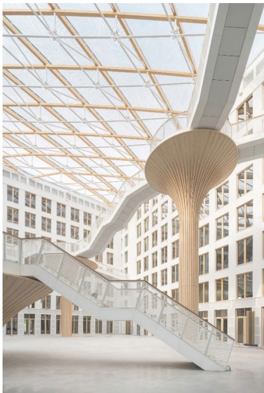
Abbildung 3: Die digital unterstützte Kombination aus Holz und Vorfertigung ermöglicht es erst, in großem Maßstab nachhaltig zu bauen.
