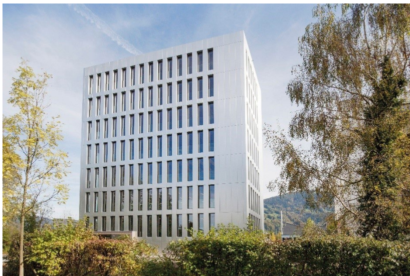
Abbildung 1: Das Bürogebäude LCT One in Dornbirn, Vorarlberg, war 2011 das weltweit erste mehrstöckige Holzhybridgebäude, das im System und mit digitaler Unterstützung errichtet wurde.
