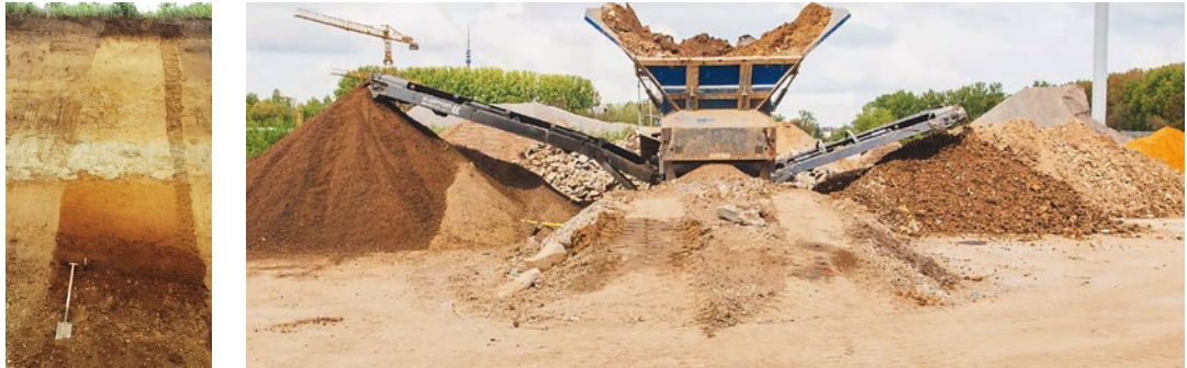
Abbildung 16: Aushubschichten (© https://www.lfu.bayern.de/boden/tag_des_bodens/2021/index.htm ), Sortieren von Aushub (©BC Materials)
